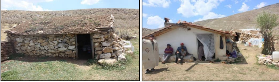
Fotoğraf 3. a) Yığma taş toprak çatılı dam b) Betonarme kiremit çatılı dam
